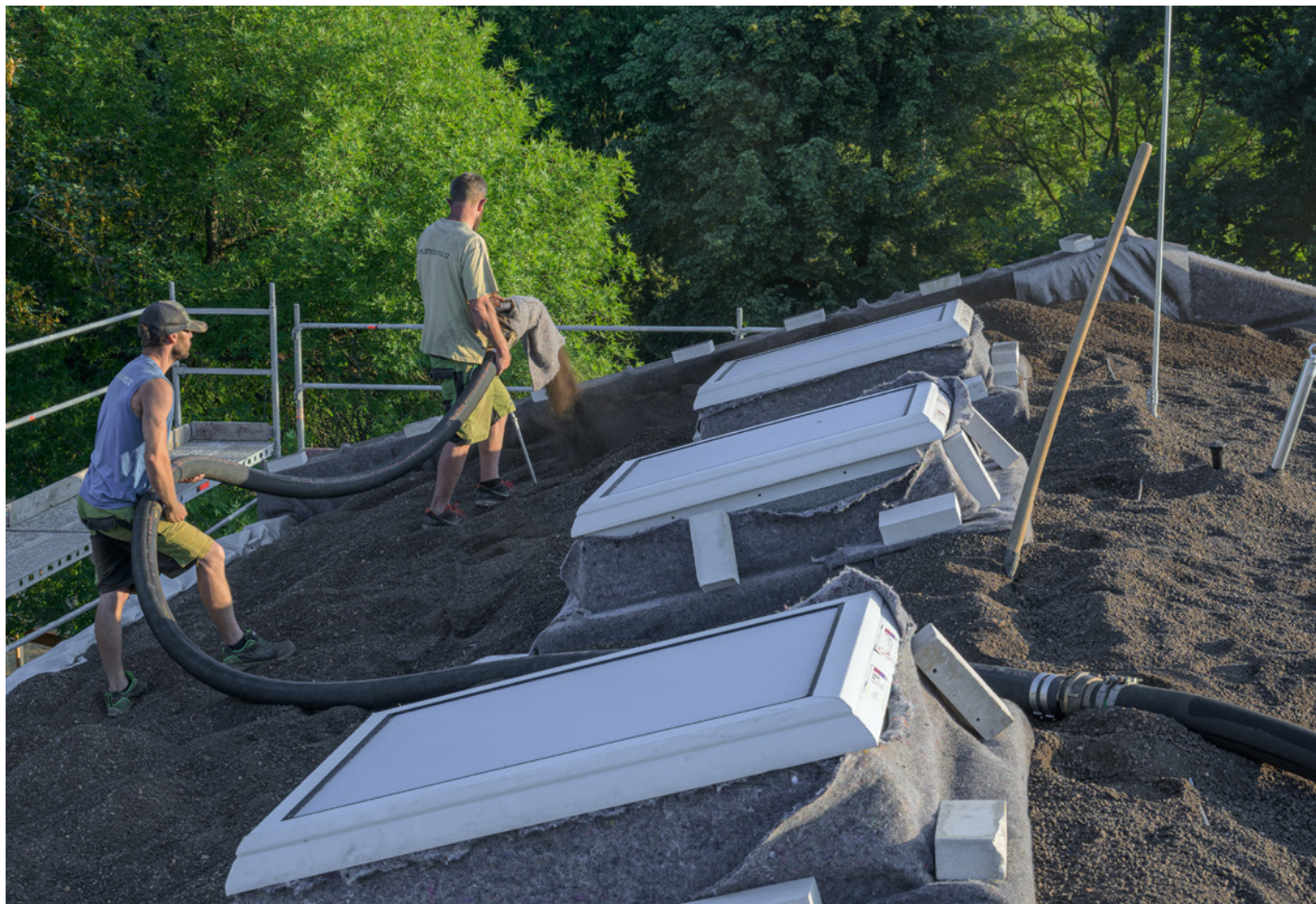
Rekonstrukce ubikace a výběhů pro koně Převalského – foukání substrátu na střešinu objektu (červenec 2023)
